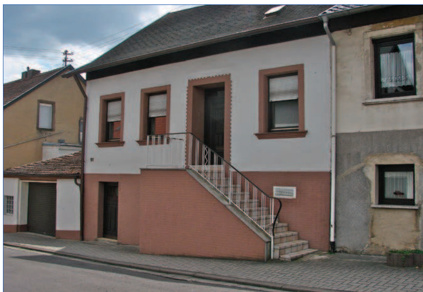
Gebäudeleerstand in der Schulstraße; Foto: Kernplan
