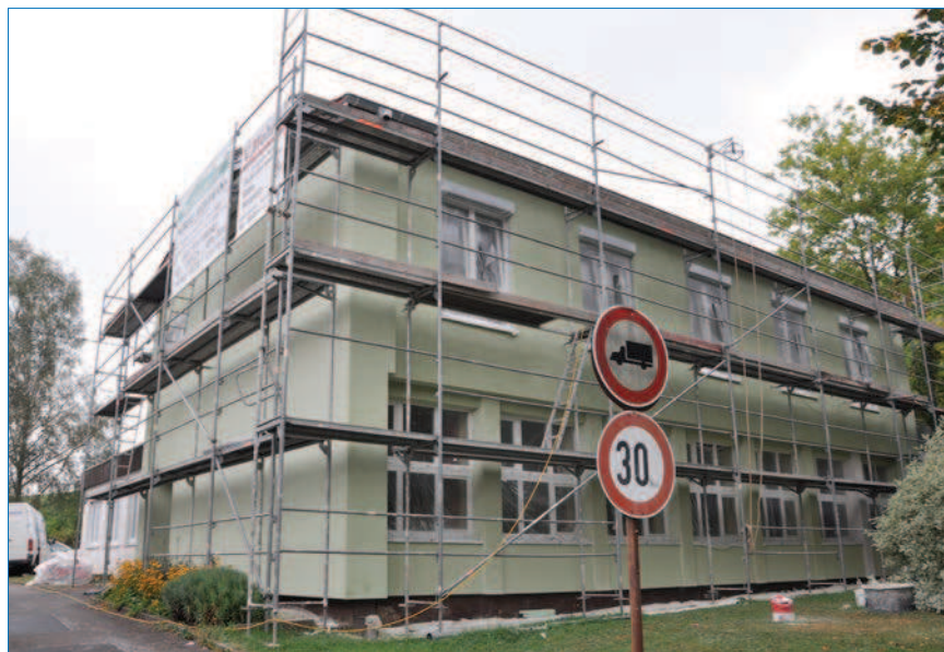
Kindergarten Hirzweiler; Foto: Kernplan
