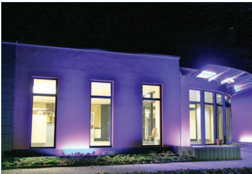
Saniertes Hallenbad in Illingen; Foto: Gemeinde Illingen
