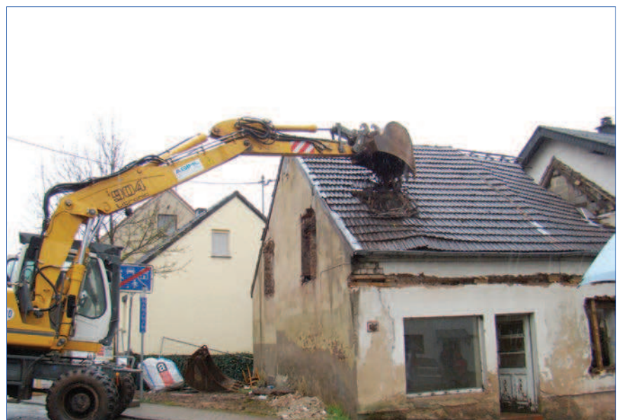
Abriss der Hausnummer 23 in der Brückenstraße Hüttigweiler; Foto: Kernplan
