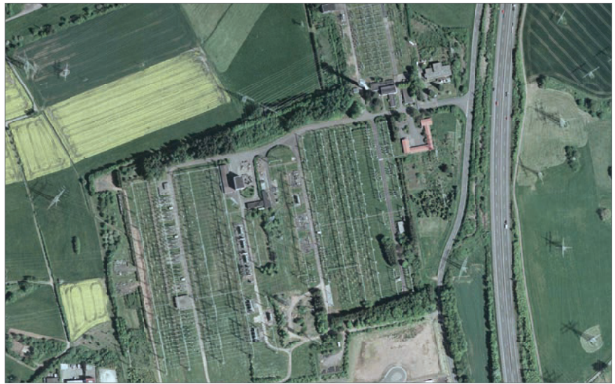
Luftaufnahme des Umspannwerkes Uchtelfangen; Foto: ZORA, LKVK
