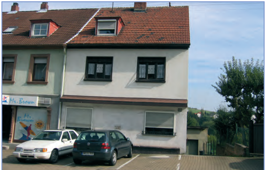
Abb. 1.39, Leerstand in der Hauptstrasse
