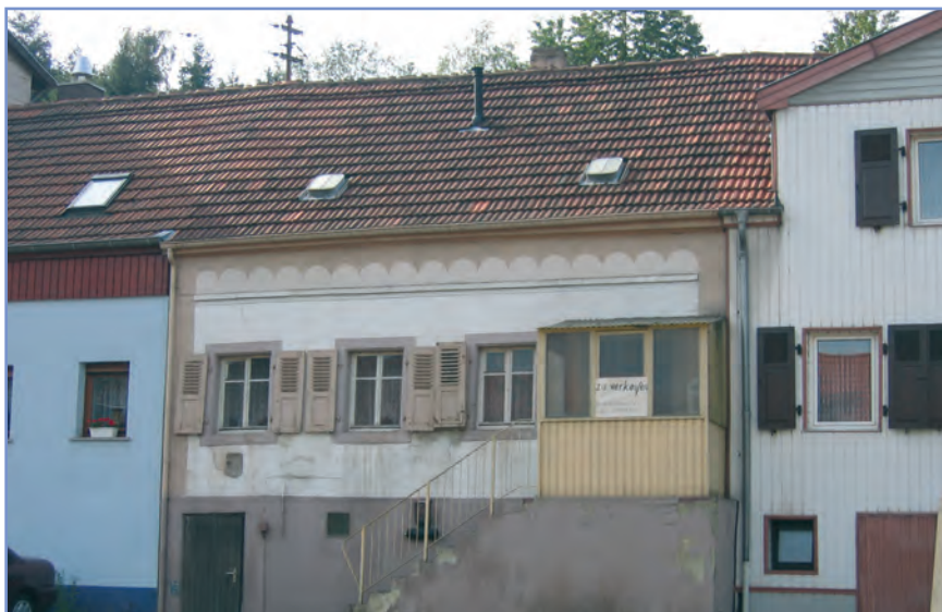
Abb. 3.4, Leerstehendes Wohnhaus in Illingen
