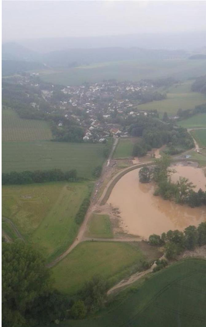
**Rückhaltebecken sind für bestimmte Abflussmengen dimensioniert.**
